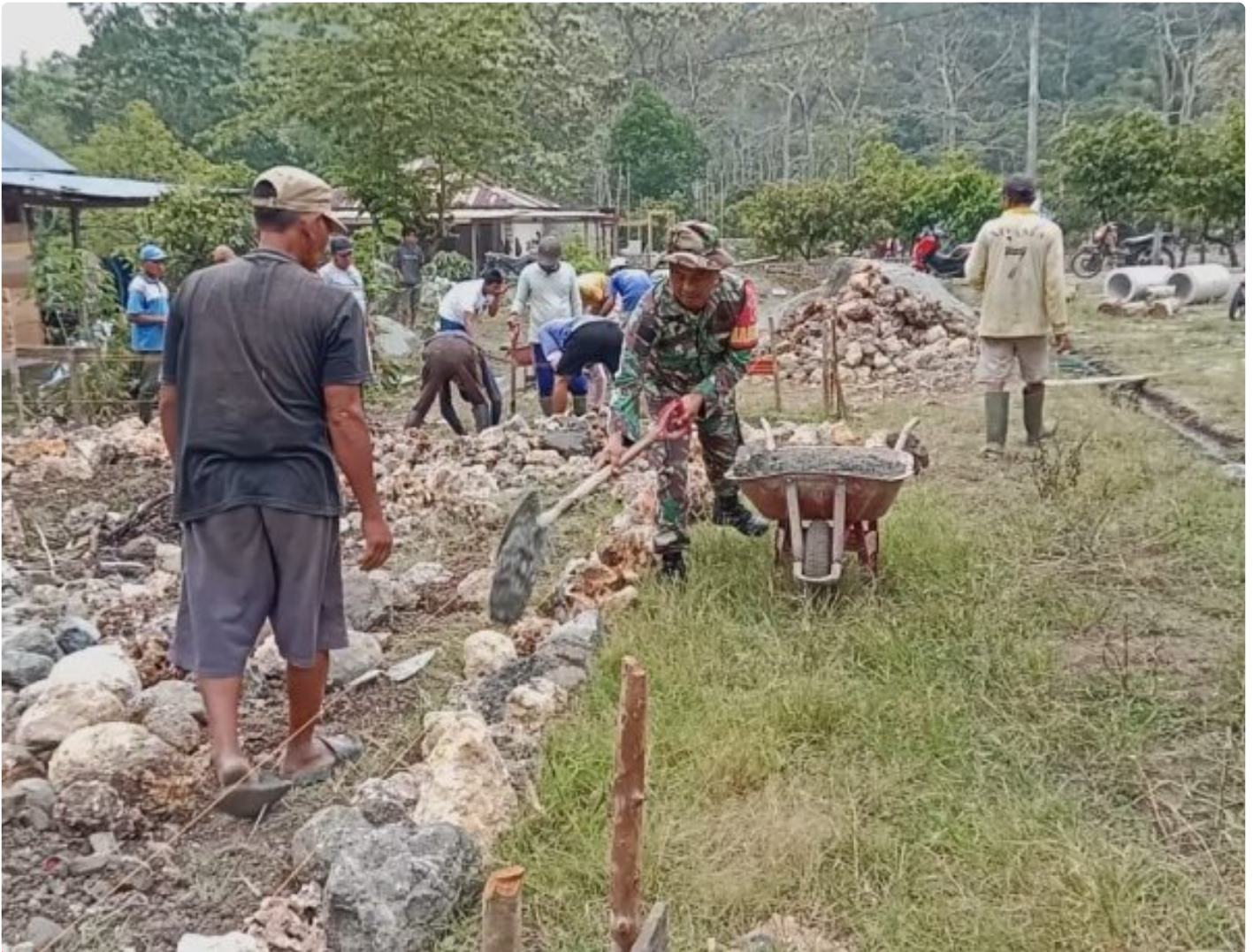
Gotong royong bangun pondasi rumah warga
